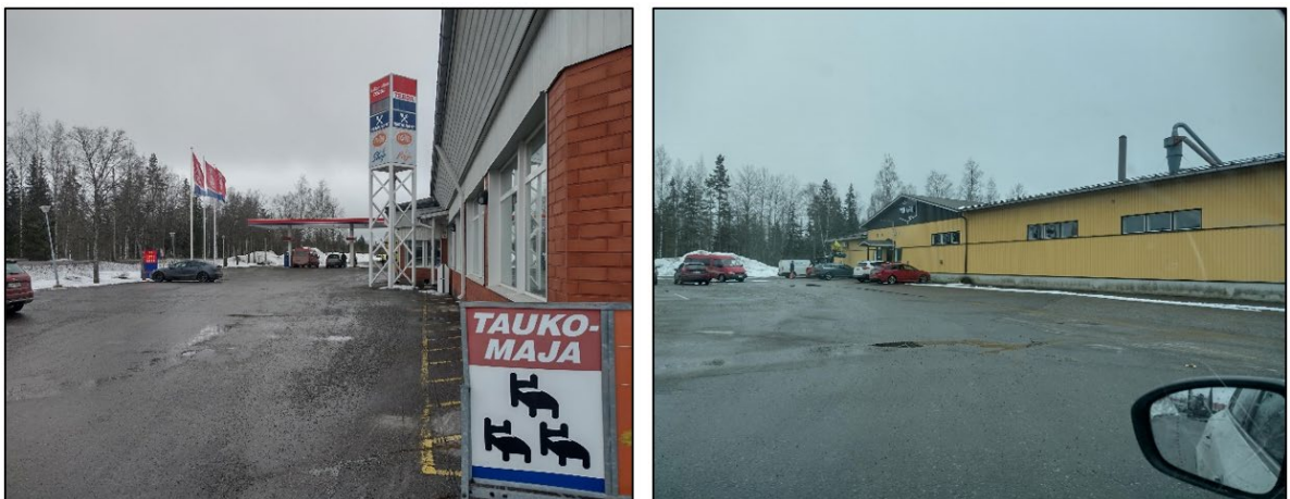
Kuva 10: Näkymiä vt 6:n eli Karjalantien luoteispuolelle sijoittuvista rakennuksista
