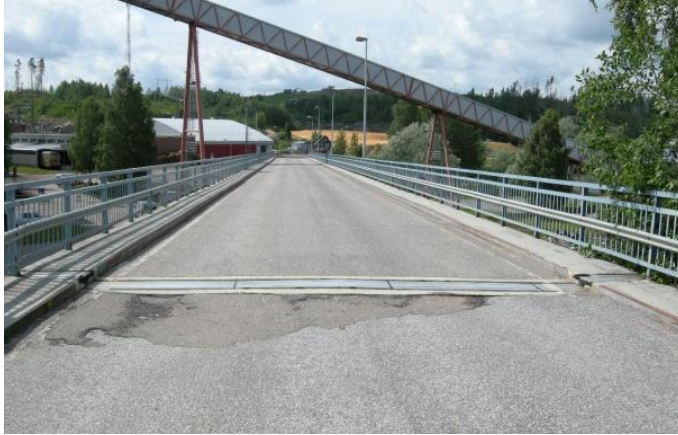
Kuva 2-10. Kokkolanjoen silta. (Sito)
