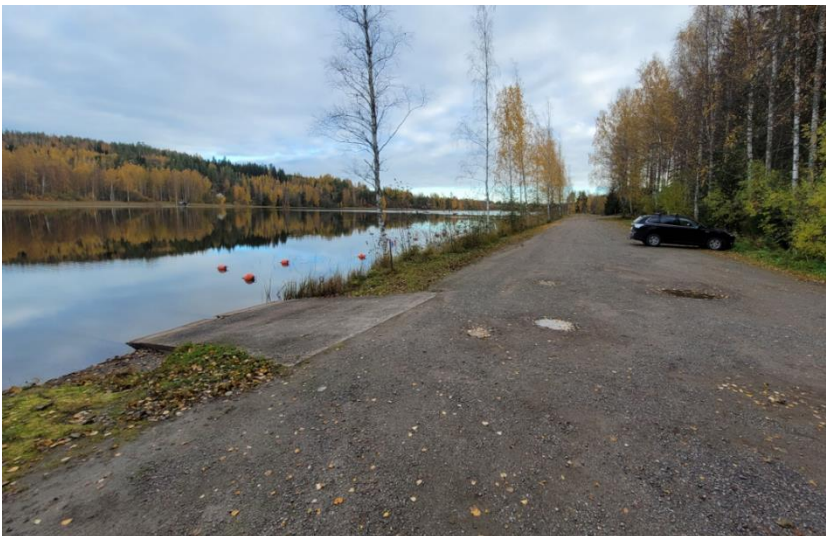
Kuva 14. Kivijärven betoninen luiska.
