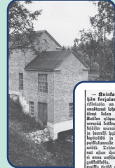
Alun perin voimalaitos oli huopakattoinen. Ovisiänkäynti johti myös alakertaan. Kuva: UPM keskusarkisto. Originally the hydropower plant had a felt roof. A door entrance also led to the lower floor. Photo: UPM central archive.
